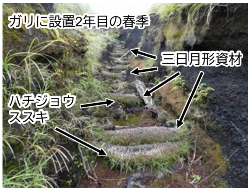
図 6-2-5 三宅島のガリに階段状設置した三日月形資材に自然定着したハチジョウススキ
