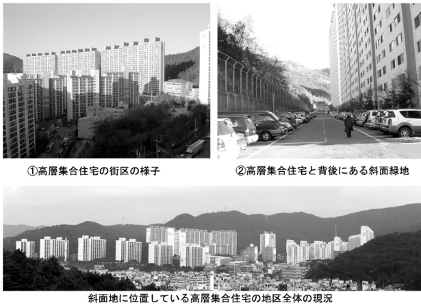
図 5 盤松洞地区の現況写真
