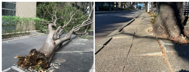
図-1 成長阻害による倒伏 (左) と根上がり (右) の事例
